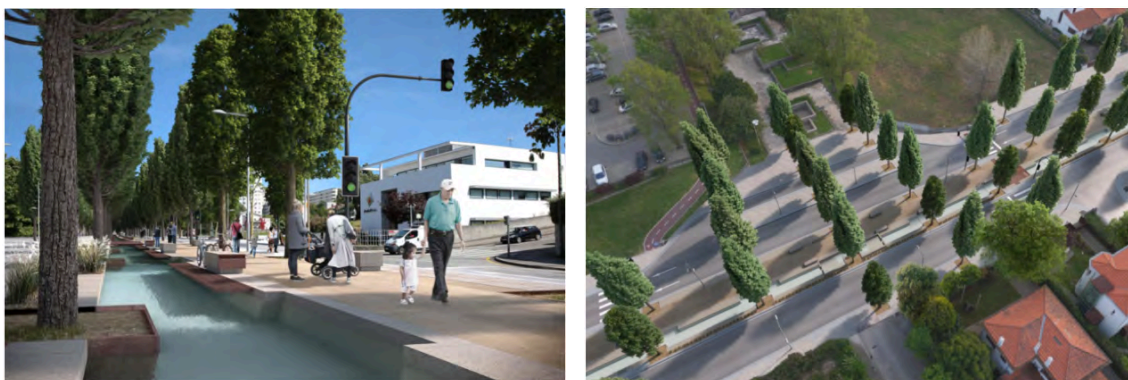
Fig. 16 | Desentubamento da ribeira de Aldoar na Avenida da Boavista
