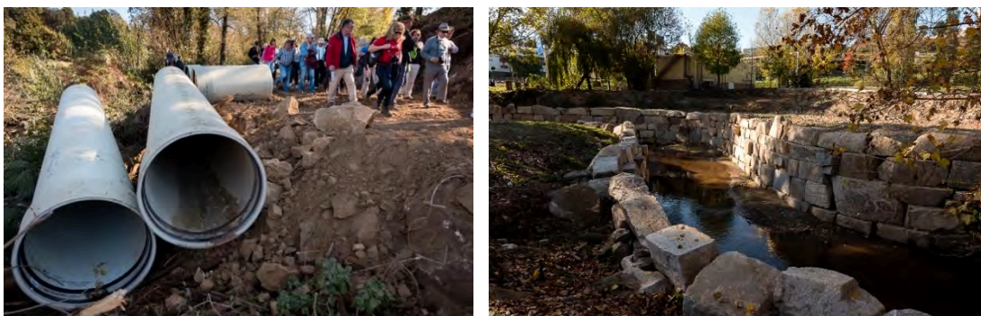
Fig. 5 | Construção do intercetor de Rio Tinto
