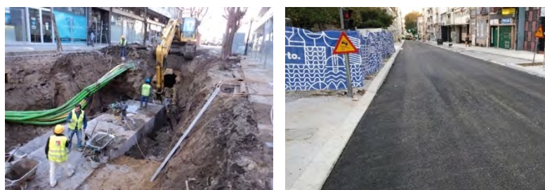
Fig. 14 Remodelação da rede de águas pluviais em Santos Pousada
