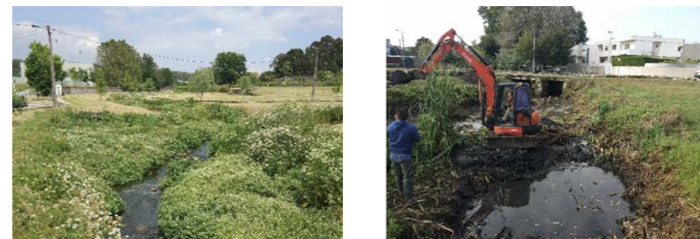
Figura 13 | Limpeza e manutenção de leito e margens das linhas de água
