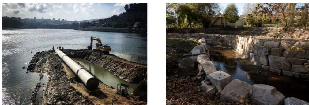
Figura 18 | Despoluição do rio Tinto através da construção do intercetor
