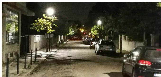
Figura 51 - Interferência da Arborização na Iluminação Pública
