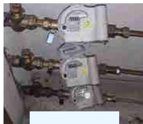
Figura 45 | Substituição de contador tradicionais por contadores com módulo de telemetria
