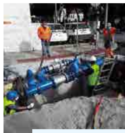
Figura 4 | “Setorização Mais”: construção de câmara de manobras e instalação de caudalímetro
